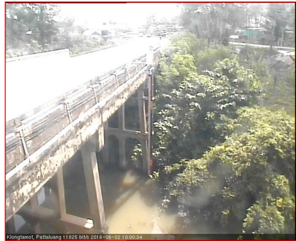
สถานีคลองตะโหมด - ต.แม่ขรี อ.ตะโหมด จ.พัทลุง (ลุ่มน้ำทะเลสาบสงขลา)
