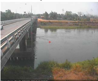
สะพานท่าเสา - อ.เมือง จ.อุตรดิตถ์ (ลุ่มน้ำน่าน)
