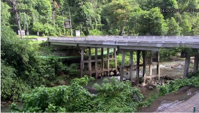
TC220303 : สะพานบ่อน้ำร้อน ต.บางริน อ.เมืองระนอง จ.ระนอง
