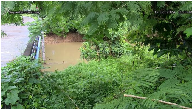
TC220512 : สะพานบ้านท่าคลอง ต.ทับปุด อ.เมืองกระบี่ จ.กระบี่
