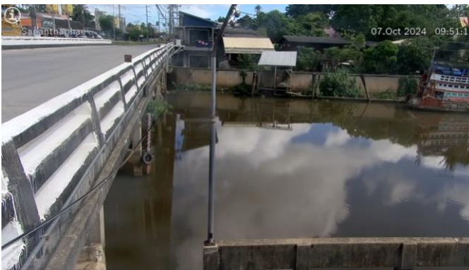
TC191911 : สะพานวัดท่าแพ ต.ปากพนอน อ.เมือง จ.นครศรีธรรมราช
