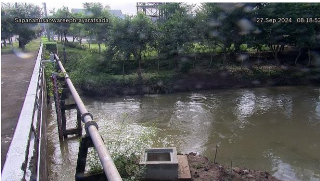
TC220904 : สะพานอนุสาวรีย์ พระยารัษฎานุประดิษฐ์มหิศรภักดี ต.ทับเที่ยง อ.เมืองตรัง จ.ตรัง
