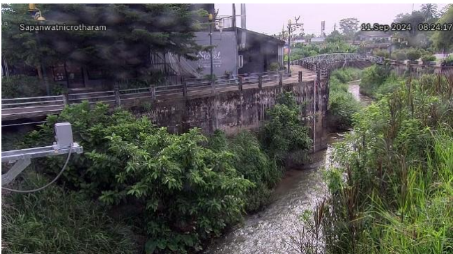
TC220509 : สะพานวัดนิโครธาราม ต.ทับปุด อ.ทับปุด จ.พังงา
