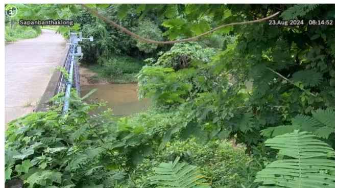
TC220512 : สะพานบ้านท่าคลอง ต.ทับปุด อ.เมืองกระบี่ จ.กระบี่
