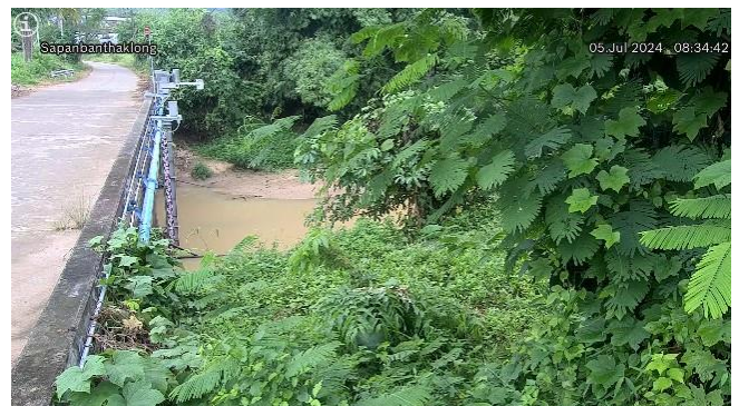
TC220512 : สะพานบ้านท่าคลอง ต.ทับปริง อ.เมืองกระบี่ จ.กระบี่
