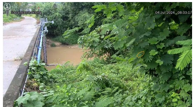
TC220512 : สะพานบ้านท่าคลอง ต.ทับปุด อ.เมืองกระบี่ จ.กระบี่
