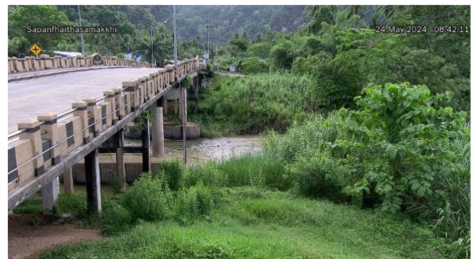
TC220510 : สะพานฝ่ายท่าสามัคคี ต.ถ้ำน้ำมุด อ.เมืองพังงา จ.พังงา
