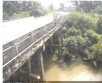
สถานีคลองตะโหมด - อ.ตะโหมด จ.พัทลุง (ลุ่มน้ำทะเลสาบสงขลา)
