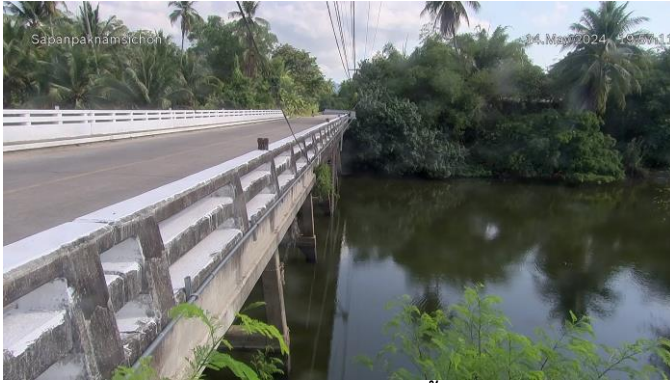
TC191705 : สะพานปากน้ำลิซล ต.ลิซล อ.ลิซล จ.นครศรีธรรมราช
