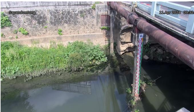
TC220605 : สะพานดำรง ต.ตลาดใหญ่ อ.เมืองภูเก็ต จ.ภูเก็ต
