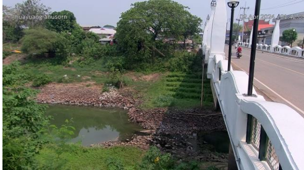
TC031703 : สะพานห้วยหลวงอนุสรณ์ ต.จุมพล อ.โพธิ์พิสัย จ.หนองคาย
