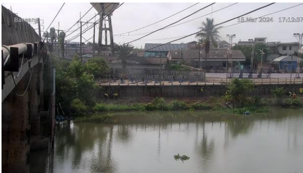
TC150503 : บ้านสร้าง ต.บ้านสร้าง อ.บ้านสร้าง จ.ปราจีนบุรี
