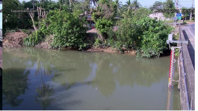
TC221203 : สะพานบ้านนาลาน
