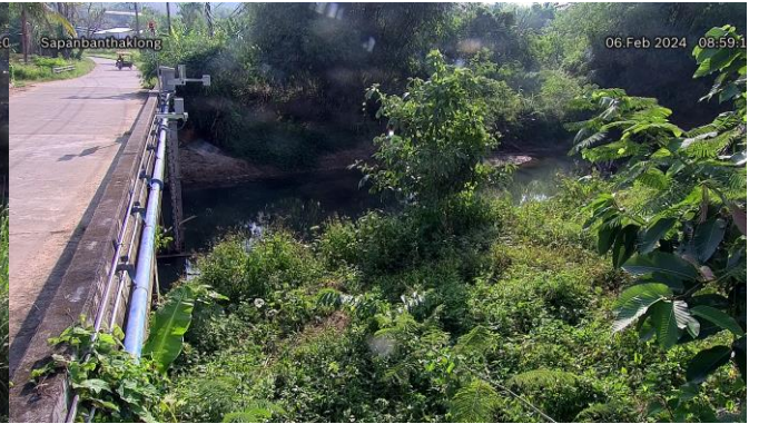
TC220512 : สะพานบ้านท่าคลอง
