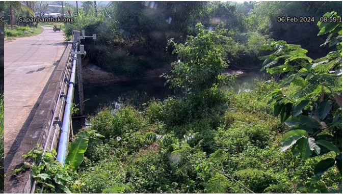
TC220512 : สะพานบ้านท่าคลอง
