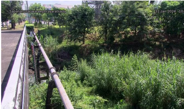
TC220904 : สะพานอนุสาวรีย์พระยารัษฎานุประดิษฐ์มหิศรภักดี ต.ทับเที่ยง อ.เมืองตรัง จ.ตรัง
