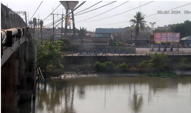
TC150503 : บ้านสร้าง ต.บ้านสร้าง อ.บ้านสร้าง จ.ปราจีนบุรี
