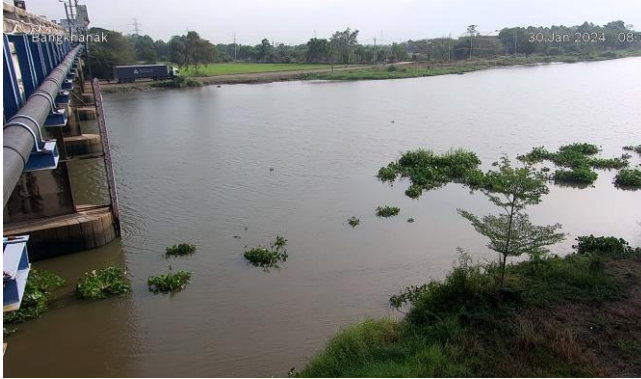
TC151002 : บ้านบางชนาก ต.บางชนาก อ.บางน้ำเปรี้ยว จ.ฉะเชิงเทรา
