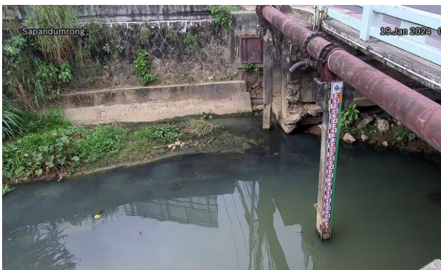
TC220605 : สะพานดำรง ต.ตลาดใหญ่ อ.เมืองภูเก็ต จ.ภูเก็ต
