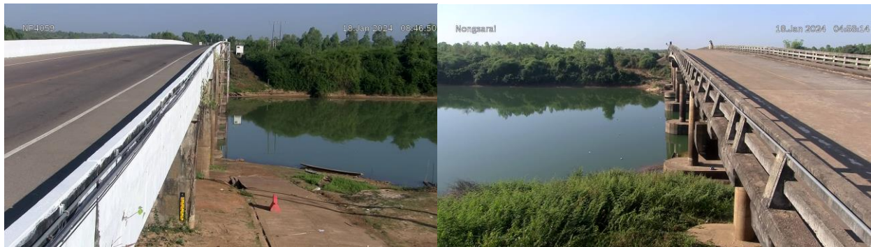
TC032705 : สะพาน นพ.4059 ต.ท่าบ่อสงคราม อ.ศรีสงคราม จ.นครพนม
