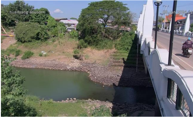
TC031703 : สะพานห้วยหลวงอนุสรณ์ ต.จุมพล อ.โพธิ์สัย จ.หนองคาย
