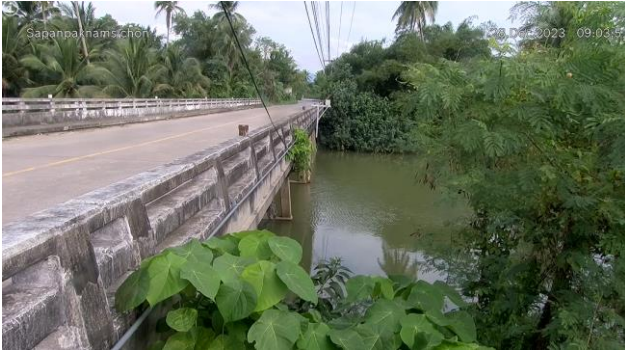
TC191705 : สะพานปากน้ำลิซล ต.ลิซล อ.ลิซล จ.นครศรีธรรมราช
