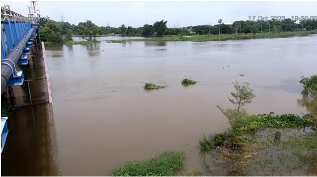
TC151002 : บ้านบางชนาก ต.บางชนาก อ.บางน้ำเปรี้ยว จ.ฉะเชิงเทรา
