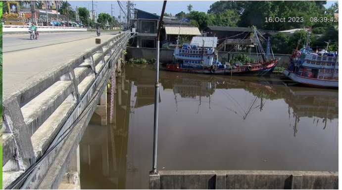
TC191911 : สะพานวัดท่าแพ ต.ปากพูน อ.เมือง จ.นครศรีธรรมราช
