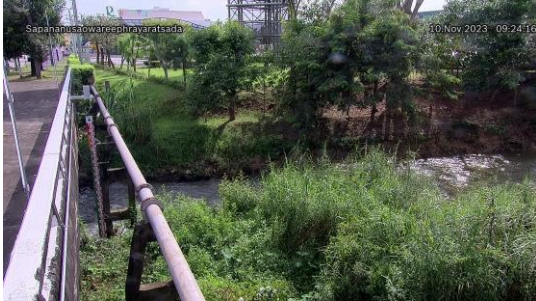
TC220904 : สะพานอนุสาวรีย์พระยารัษฎานุประดิษฐ์ มทิสรรักดี ต.ทับเที่ยง อ.เมืองตรัง จ.ตรัง
