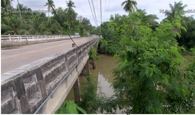
TC191705 : สะพานปากน้ำลิซล ต.ลิซล อ.ลิซล จ.นครศรีธรรมราช
