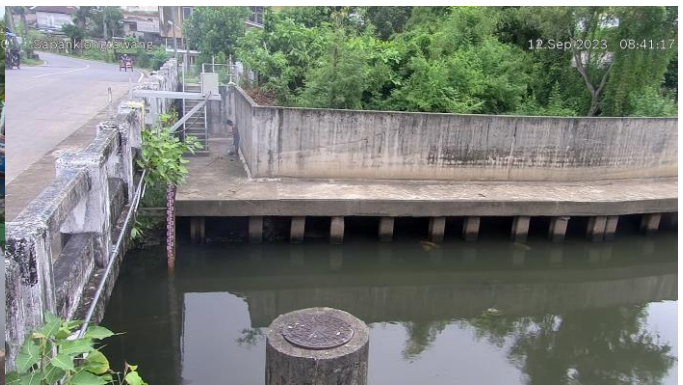
TC191912 : สะพานคลองท่าวัง เทศบาลนครนครศรีธรรมราช อ.เมือง จ.นครศรีธรรมราช
