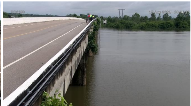
TC032705 : สะพาน นพ.4059 ต.ท่าบ่อสงคราม อ.ศรีสงคราม จ.นครพนม
