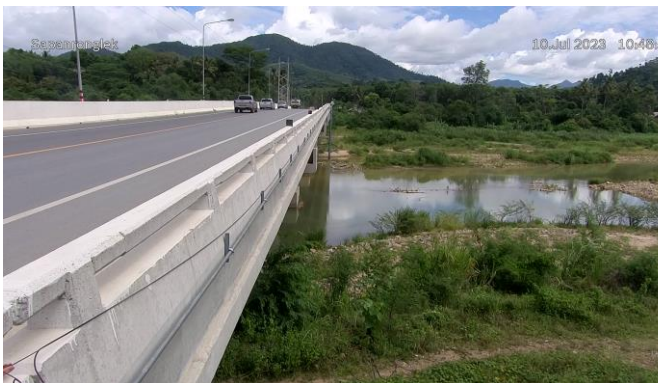
TC191802 : สะพานบ้านโรงเหล็ก ต.นบพิตดำ อ.นบพิตดำ จ.นครศรีธรรมราช
