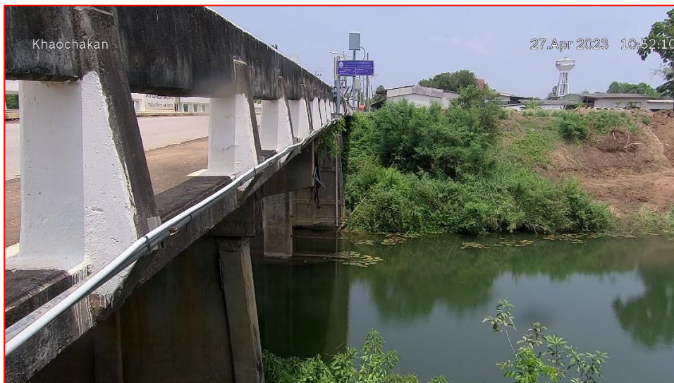
สถานีบ้านเก่าเขาฉกรรจ์ ต.หนองหว่า อ.เขาฉกรรจ์ จ.สระแก้ว (ลุ่มน้ำบางปะกง – คลองพระสทิง)
