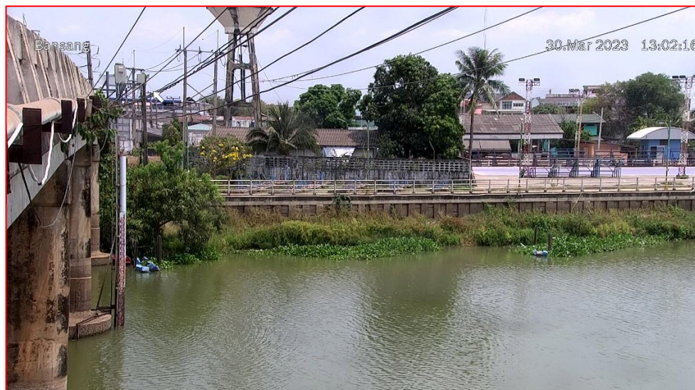
สถานีบ้านสร้าง ต.บ้านสร้าง อ.บ้านสร้าง จ.ปราจีนบุรี (ลุ่มน้ำบางปะกง – แม่น้ำปราจีนบุรีตอนล่าง)
