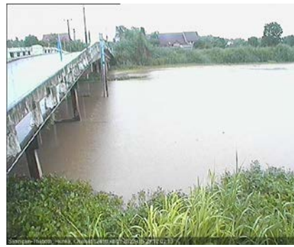
สะพานสามง่าม-ท่าโบสถ์ อ.หันคา จ.ชัยนาท (ลุ่มน้ำท่าจีน)
