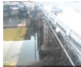
สถานีสูบน้ำคอนล่าง - อ.หาดใหญ่ จ.สงขลา (ลุ่มน้ำทะเลสาบสงขลา)
