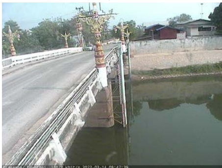
สะพานพระแม่ย่า - อ.เมือง จ.สุโขทัย (ลุ่มน้ำยม)
