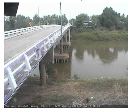
สะพานเฉลิมพระเกียรติ 48 พรรษา อ.เมือง จ.พิจิตร (ลุ่มน้ำ่าน)
