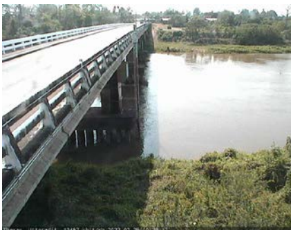
สะพานท่าเสา - อ.เมือง จ.อุตรดิตถ์ (ลุ่มน้ำ่าน)
