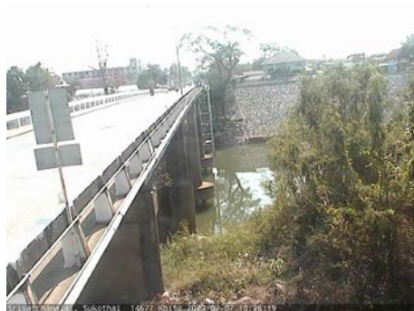
สะพานศรีรัตนาลัย - อ.ศรีรัตนาลัย จ.สุโขทัย (ลุ่มน้ำยม)
