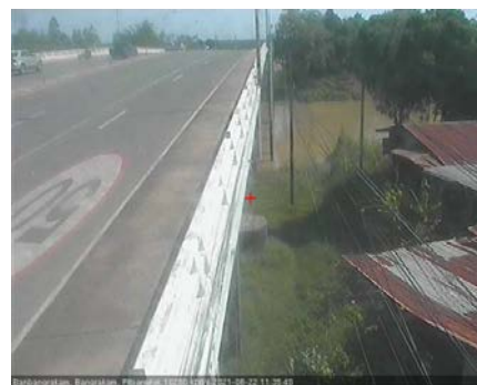
สะพานบางระกำ - อ.บางระกำ จ.พิษณุโลก (ลุ่มน้ำยม)
