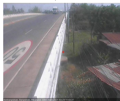
สะพานบางระกำ - อ.บางระกำ จ.พิษณุโลก (ลุ่มน้ำยม)
