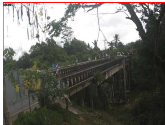
สถานีสะพานบ้านบางศาลา - ต.บ้านพรุ อ.หาดใหญ่ จ.สงขลา (ลุ่มน้ำทะเลสาบสงขลา)
