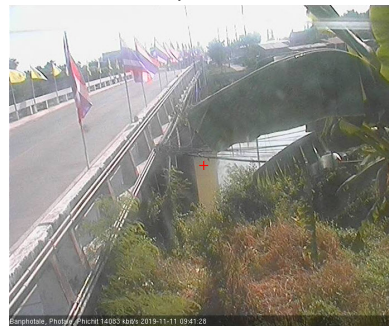
สะพานบ้านโพทะเล - อ.โพทะเล จ.พิจิตร (ลุ่มน้ำยม)
